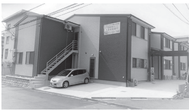
▲東大阪市の住宅型有老(写真はホームページより)
